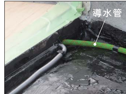
導水管を直接ジョイントドレーンに 接続することもできます。
