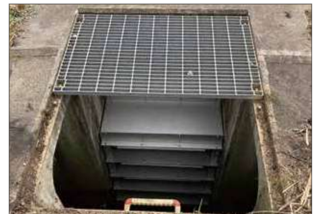
設置完了（1基目）
