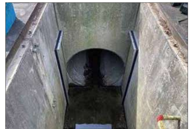
製品枠設置完了
