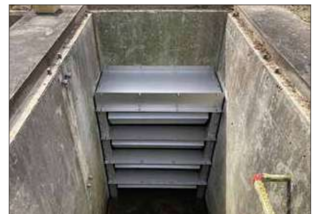
設置完了（2基目）
